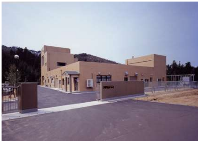
【最終処分場 浸出水処理施設】
